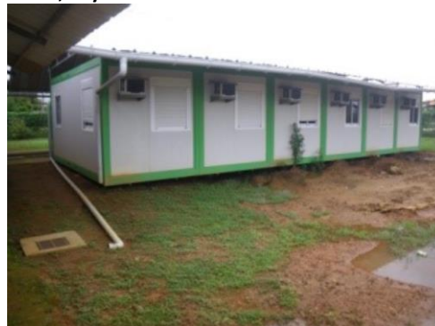
Salles de classe bungalows au Lycée Melkior-Garré, Cayenne
