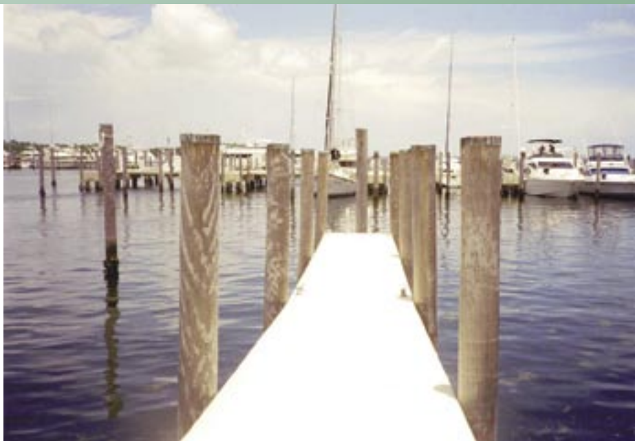
Une passerelle en EMU: Pieux de greenheart du Guyana à Miami (Etats-Unis). Photo: Demerara Timbers Limited
