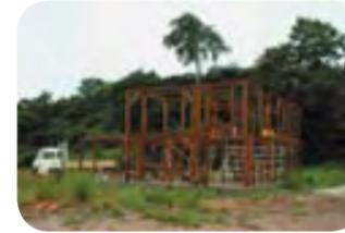
Cette maison est construite avec une ossature en bois. La dalle de l'étage est en béton coulé sur des panneaux de triply. L'ossature bois est plus légère, elle permet de faire des économies sur les fondations de la construction.
