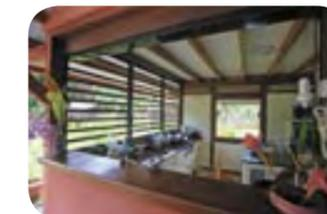
Les fenêtres de la cuisine sont des jalousies en verre. Ce dispositif permet d'ouvrir entièrement la surface de la fenêtre et de régler la ventilation à sa guise.
