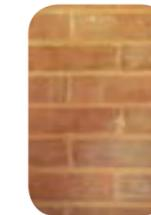
Les murs du bureau de la maison sont en briques de terre cuite. La brique permet de jouer avec l'inertie thermique. Elle contribue aussi à un isolement performant des murs car la brique a une faible conductivité thermique.
