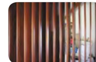
L'air chaud est évacué par des barreaudages en partie haute du mur Ouest. Un mur traversant permet de cacher en partie un débarras tout en assurant la ventilation naturelle de traverser.
