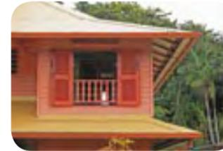
La toiture et les murs sont de couleur claire. Un isolant sous toiture de 8 cm de polystyrène expansé protège le toit de l'ensoleillement. La terrasse est elle aussi isolée avec 4 cm d'isolant. Pas de vitres à l'étage, mais des volets persiennés pour favoriser la ventilation naturelle.
