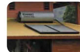
Un champ photovoltaïque de 5 kWc est raccordé au réseau électrique EDF et fait office d'abri pour la voiture. Avec le chauffe-eau solaire de 300 L, la maison compense ses besoins en eau chaude.
