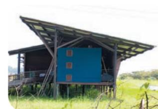
Le bâtiment est très bien protégé du soleil sur les façades Est et Ouest. La toiture est disposée en écope afin de créer une dépression accélérant la vitesse de l'air à l'intérieur du bâtiment.
