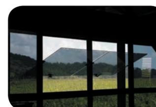
Les vitrages du bâtiment sont équipés d'un film réfléchissant performant permettant de réduire le rayonnement solaire. Les vitrages favorisent néanmoins l'éclairage naturel.
