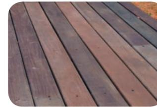
Une surtoiture en platelage bois imputrescible a été placée au-dessus des locaux climatisés pour renforcer l'efficacité des 4 cm d'isolation.
