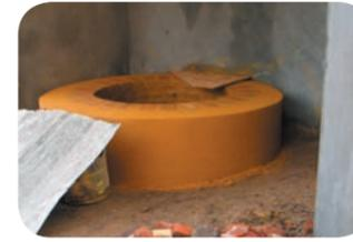
Les eaux de pluie sont partiellement renvoyées dans le puits existant. Il a été restauré, les briques remontées, rejointoyées et enduites à la chaux.
