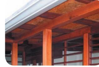
Les débords de toiture permettent de protéger des rayons du soleil et de la pluie. En cas de soleil rasant, les jalousies bois protègent les vitrages d'un effet de serre excessif.
