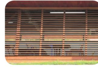
La ventilation naturelle permet de rafraîchir par évapo-transpiration. Ici, l'air traverse entièrement le bâtiment de part et d'autre. La façade sous le vent a une porosité exceptionnelle.
