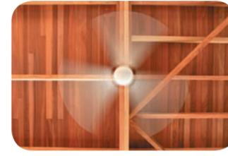
Les brasseurs d'air au plafond permettent de ventiler lorsqu'il n'y a pas assez de vent. Il y a deux brasseurs d'air par salle de classe. Ils sont commandés par un variateur électrique mural.
