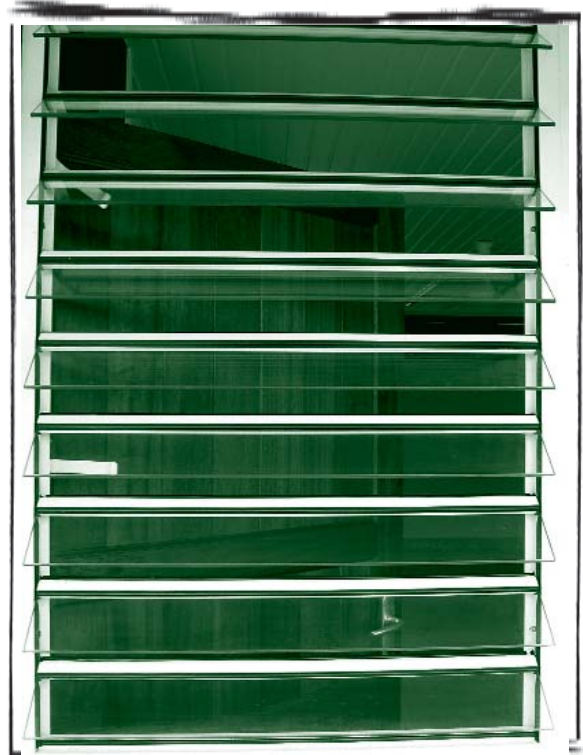
Jalousies sécurisées pour favoriser la ventilation naturelle (Collège Grand-Santi - architecte : S.Lafontaine)
