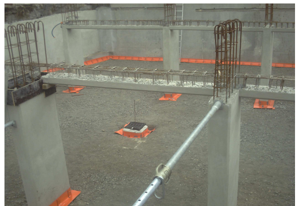
KORDON ® (BAYER) Mise en œuvre sur une partie de l'assise du bâtiment
