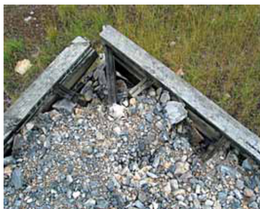
Figure 23 - Mauvaise conception du coin.
