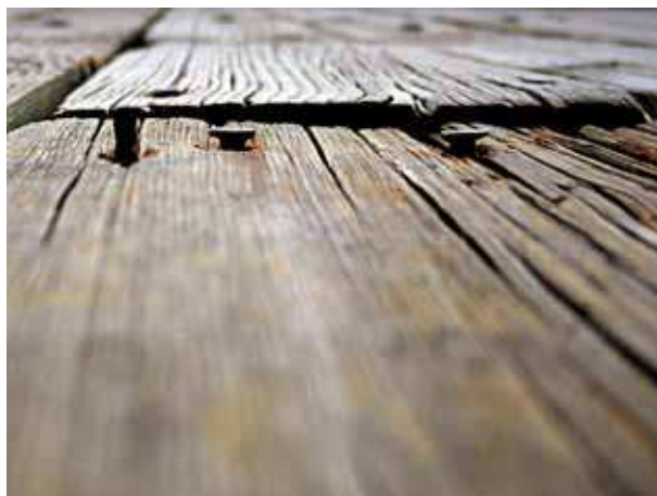
Figure 69 - Déclouement du platelage.
