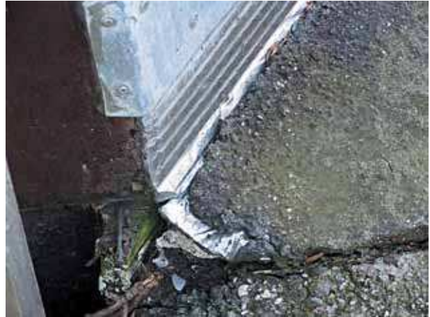
Figure 40 - Liaison poutre tablier et chaussée d'accès.
