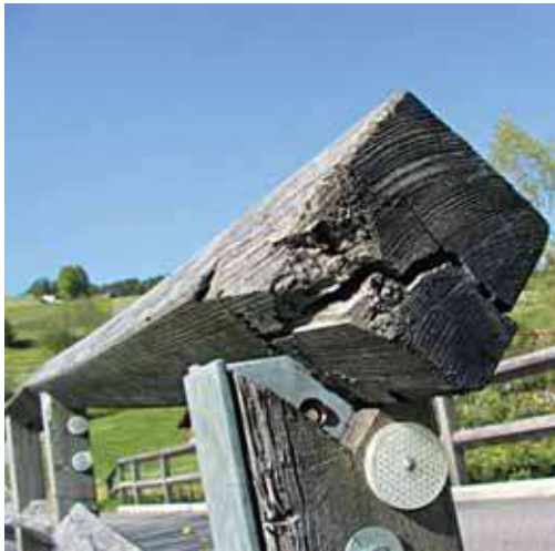
Figure 25 - Attache de la main courante sous-dimensionnée.
