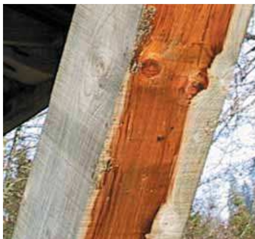
Figure 10 - Exemple de grisaillement du bois.
