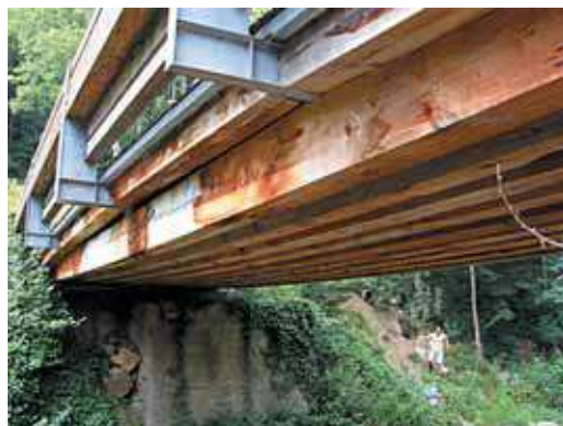
Figure 48 - Décolorations du bois inégales. Zones plus humides à ausculter.
