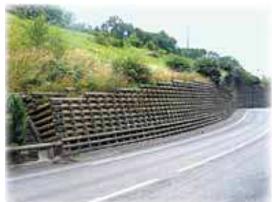
Mur de soutènement
