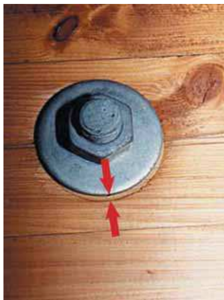
Figure 67 - Déplacement d'assemblage.
