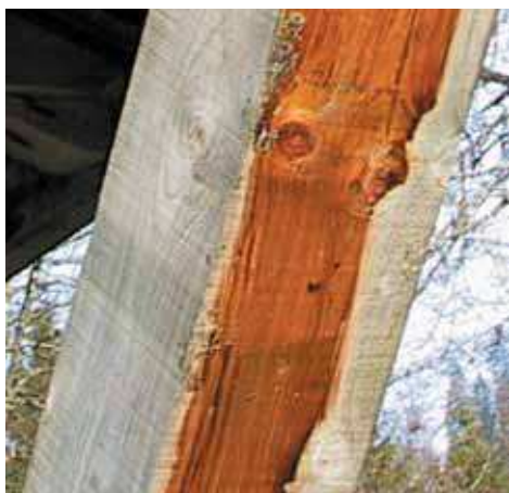
Figure 72 - Grisaillement du bois sur les faces soumises aux UV.
