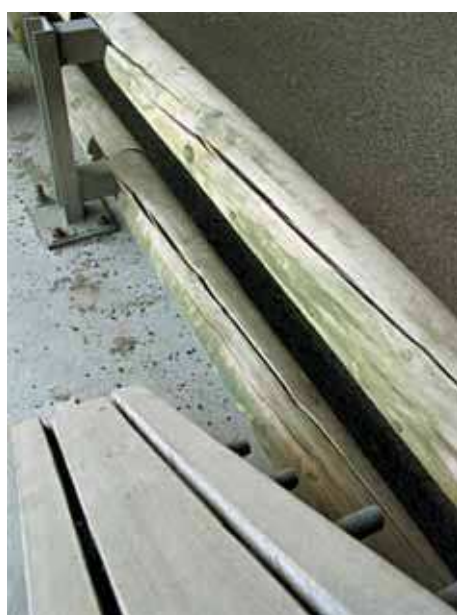
Figure 65 - Fente de retrait sur du bois rond.
