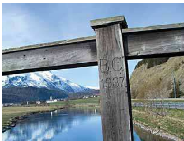
Figure 73 - Grisaillement uniforme.
